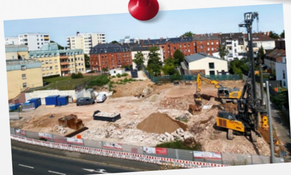
Baustelle Poppenreuther Str. 13
